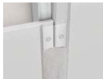
Jointoiment des plaques à bords amincis
